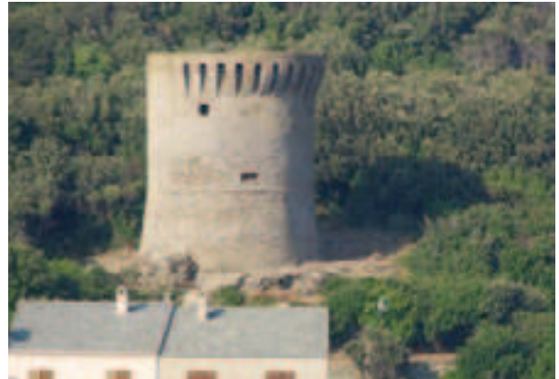
La tour de Meria rénovée
