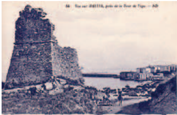
Derniers vestiges de la tour de Toga
